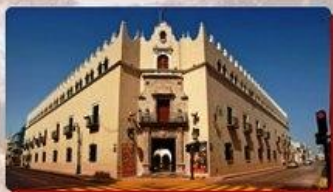
Centro Cultural Universitario Edificio Central de la Universidad Autónoma de Yucatán
